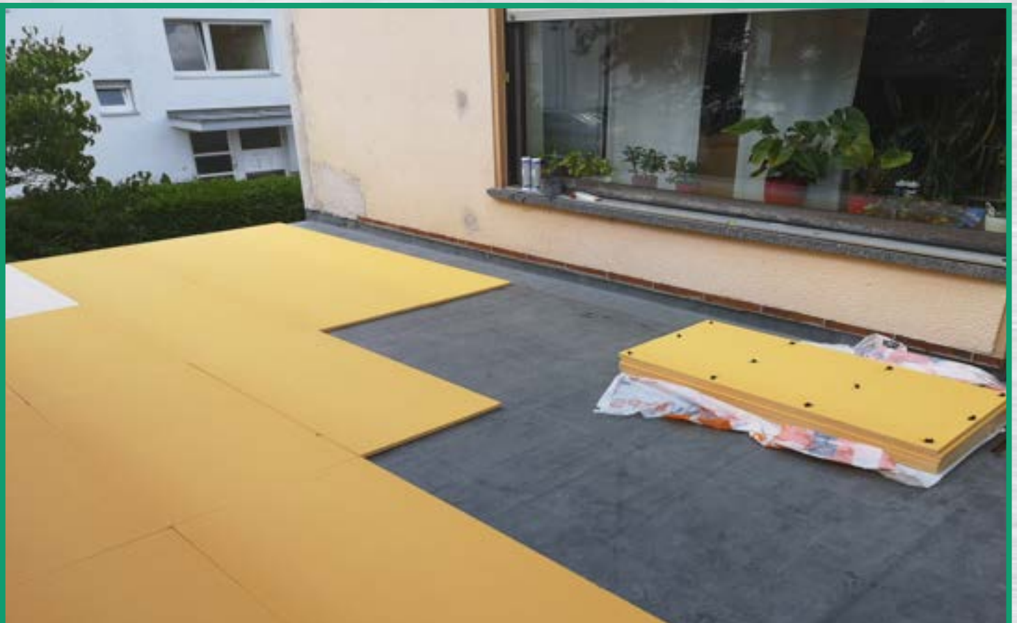
Dampfsperre und Wärmedämmung
