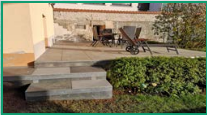
Treppenabgang von der Terrasse
