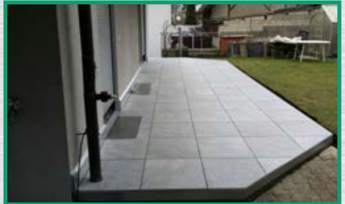
Abschrägung und Einarbeitung von Gitterrost
