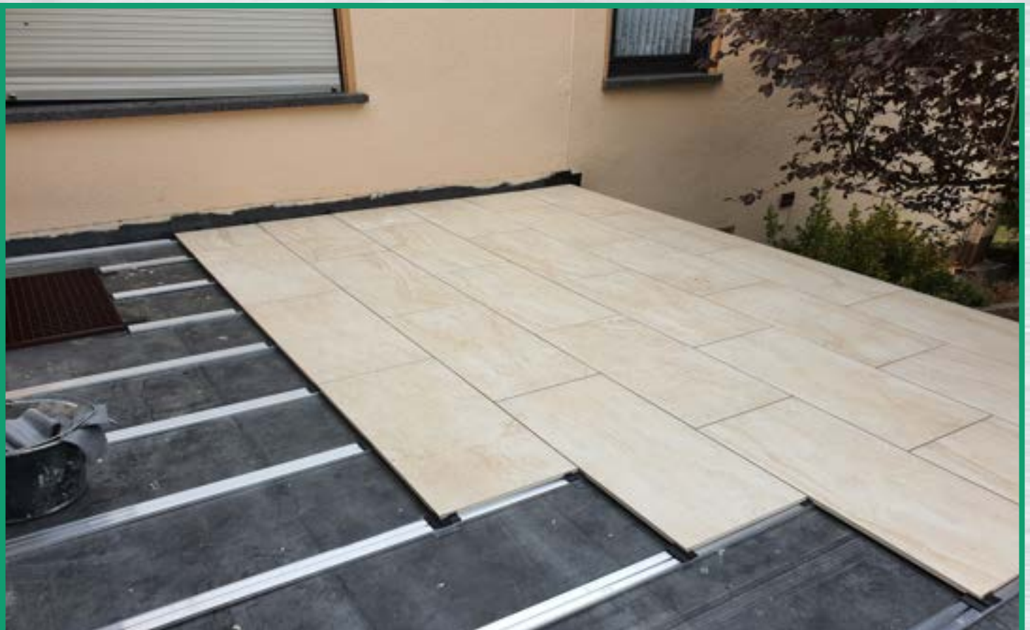
Verlegung der Fliesen auf BD - Drainage 80
