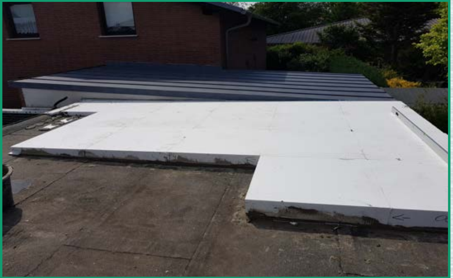
Flachdachsanierung mit Gefälle - EPS
