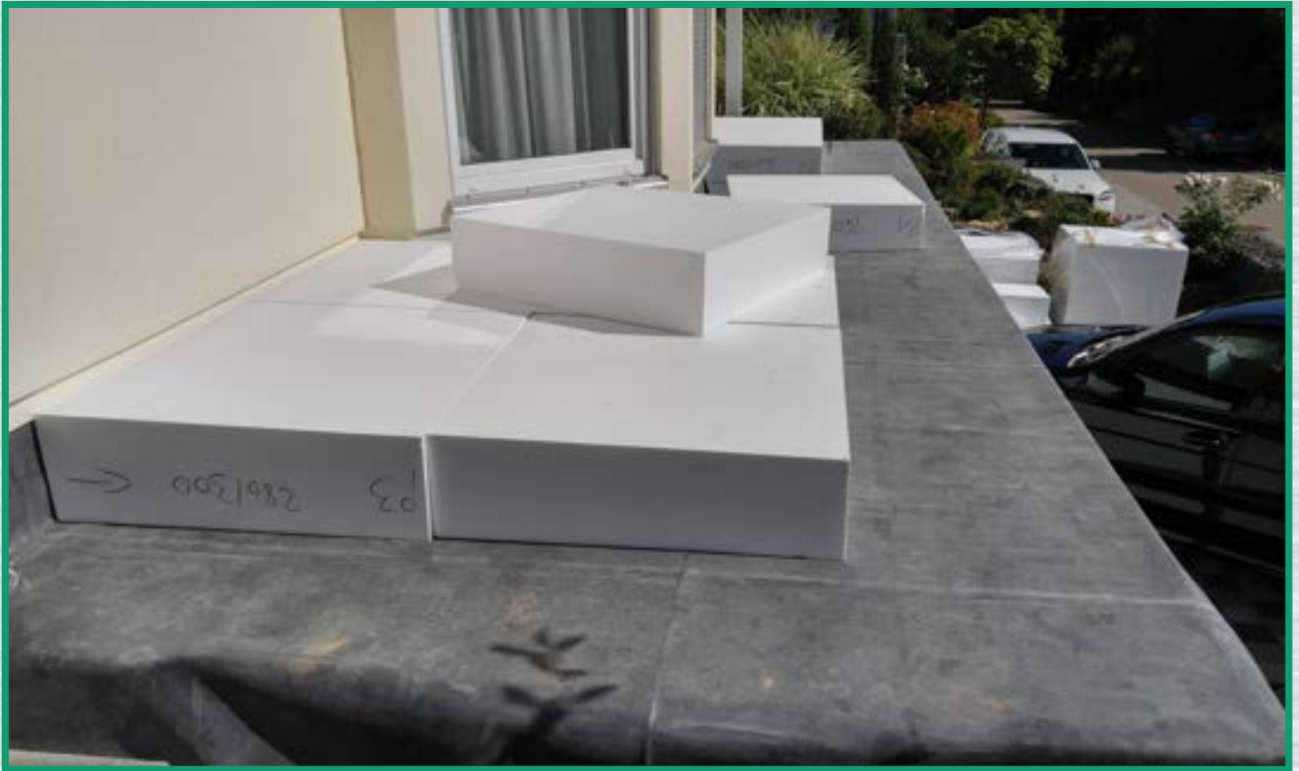
Wärmedämmung hier 30 cm
