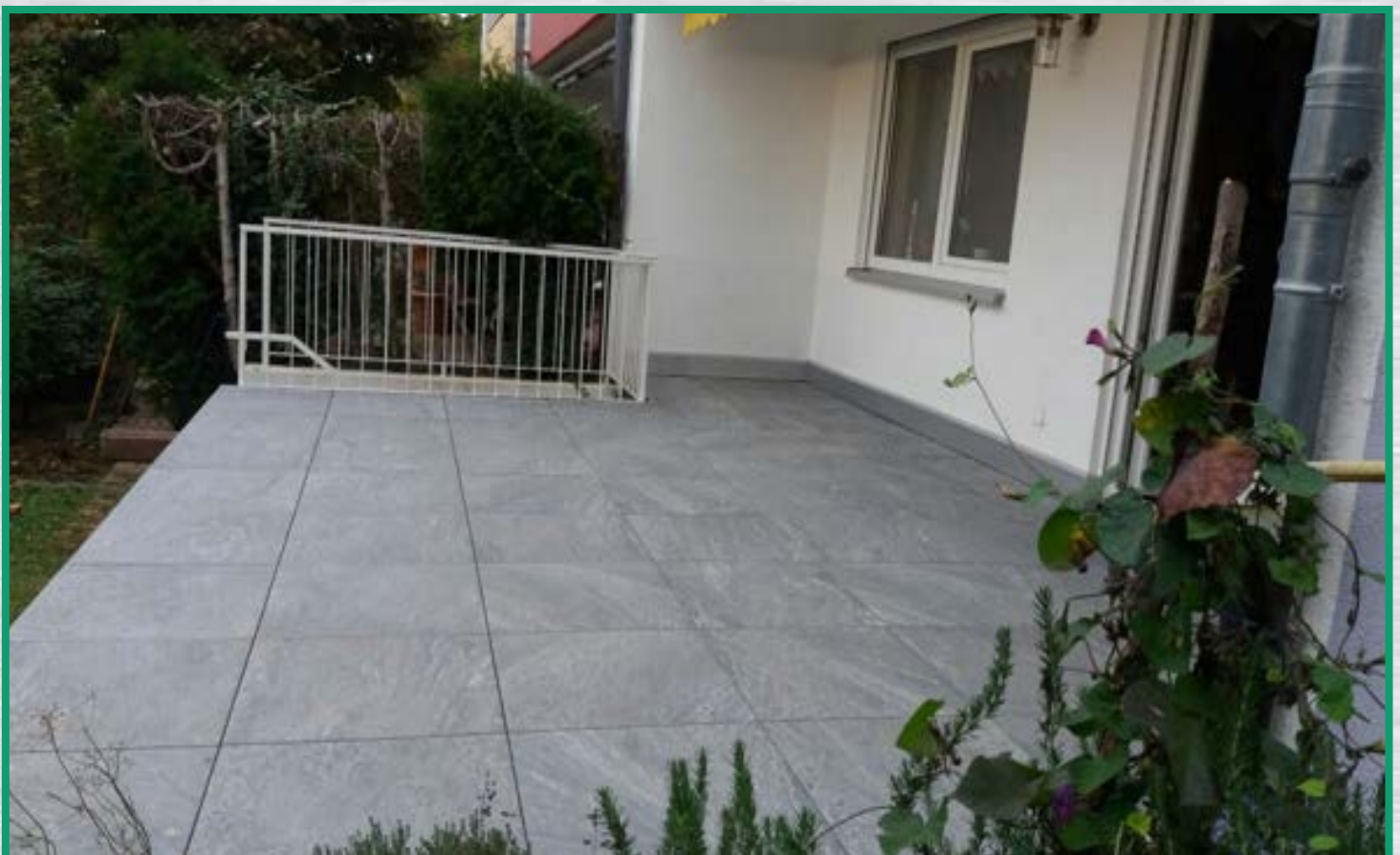
Terrasse 10 cm höher gelegt und Erweiterung um 2 Platten
