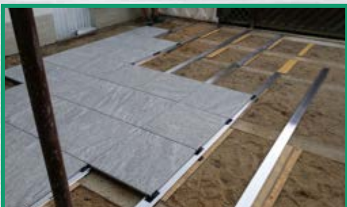
So baut man Terrassen auf Sand. Hier: mit 40 Einzelfundamenten
