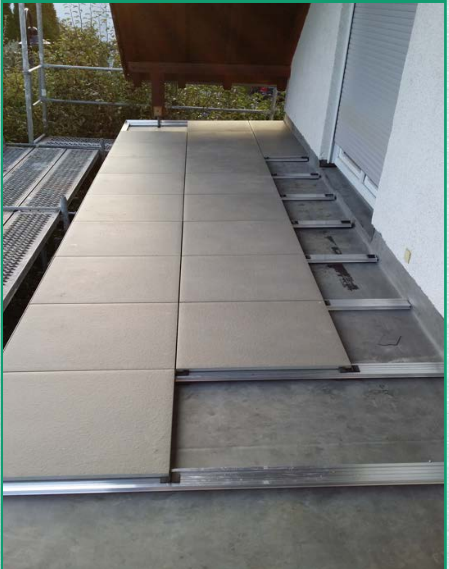
BD - Drainagesystem 80 und Bella - Terrazza - Ceramics
