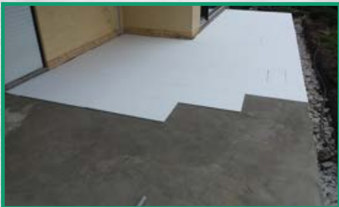
Fliesestrich wurde aufgebracht und Styropor
