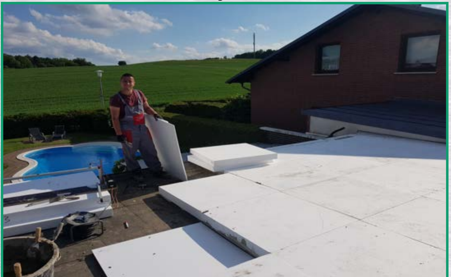
Flachdachsanierung mit Gefälle - EPS
