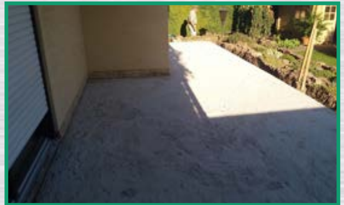
Nun ist die Betonplatte freigelegt
