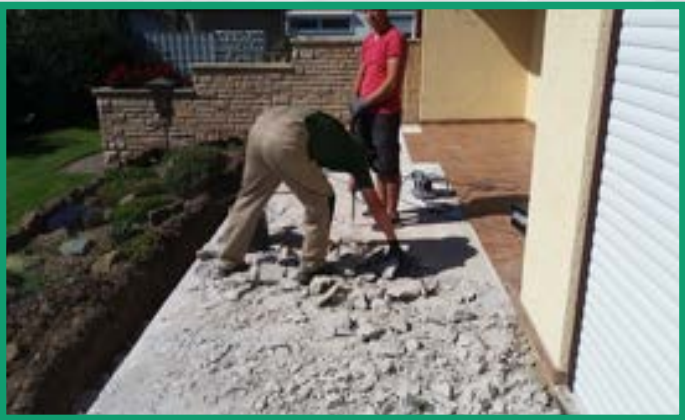
Abtragen von Fliese und Estrich
