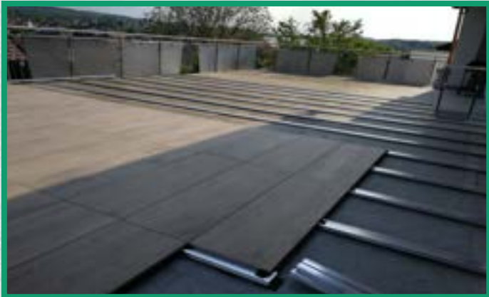
Während der Plattenverlegung
