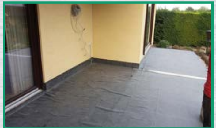
Abdichtung wurde verlegt
