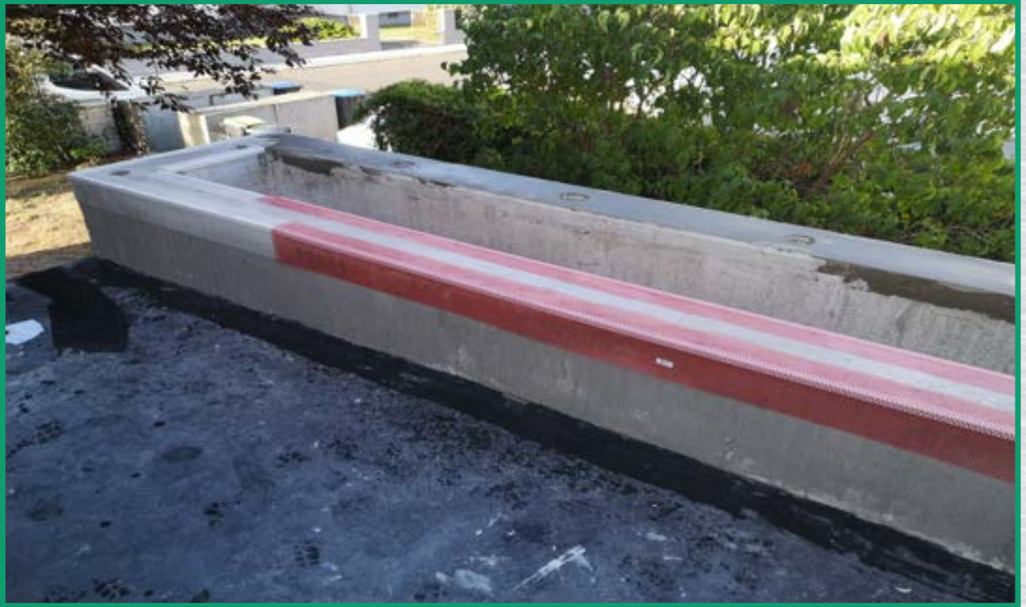
Blumenbeet wird verputzt
