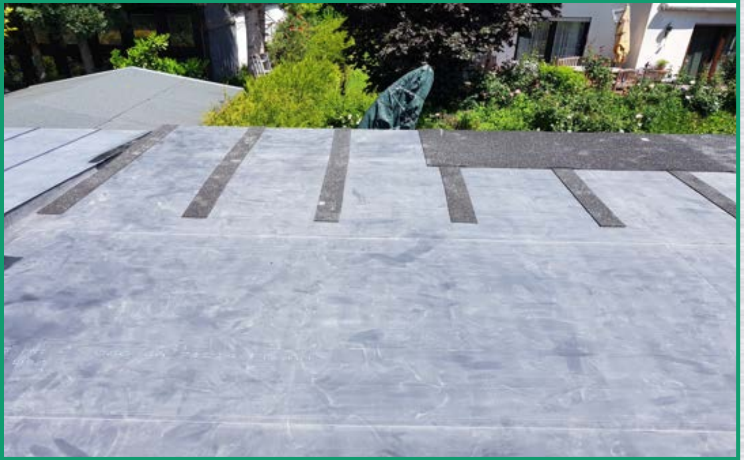
Flachdachsanierung mit Gefälle - EPS
