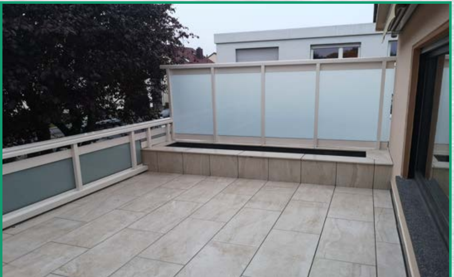
Die fertige Terrasse mit Blumenbeet, Sichtschutz aus Glas, Geländer und Feinsteinzeug 31
