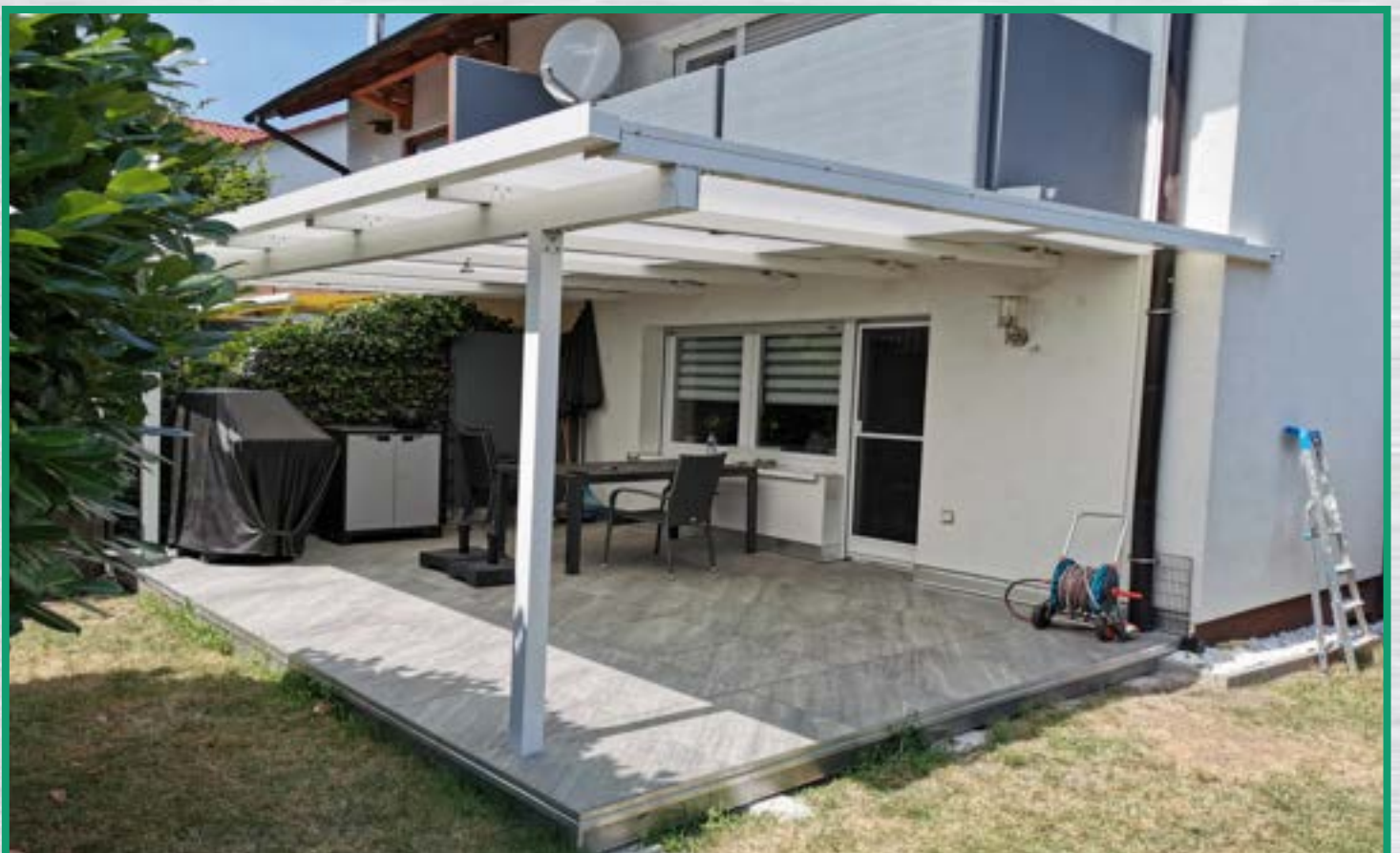
Terrasse wurde vergrößert und eine Überdachung mit LED Beleuchtung neu gebaut
