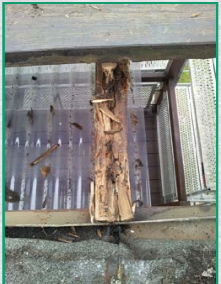
Verfaultes Holz unter den Trittböhlen
