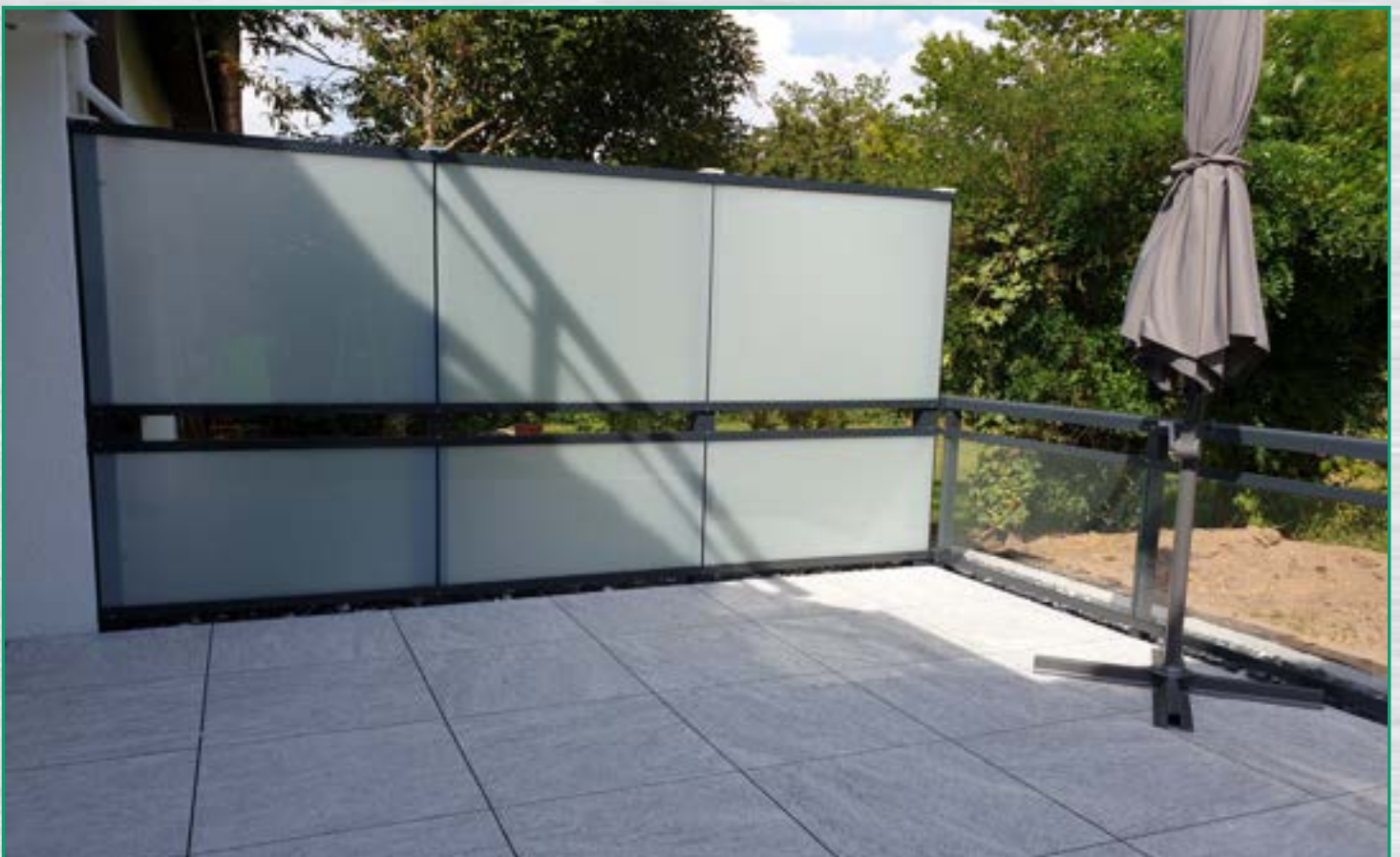
Terrasse mit Feinsteinzeug, Sichtschutz und Geländer
